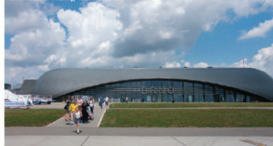
Letiště Brno-Tuřany, odletová hala
